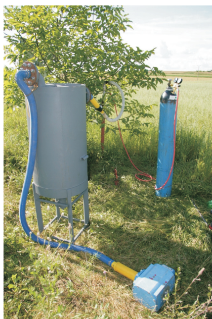
Fot. 2. Instalacja ciśnieniowego udrażniania perforacji sondy azotem
