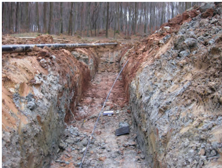
Rys. 7. Wykop do odwiertu Str.13. Pstre łupki górne
