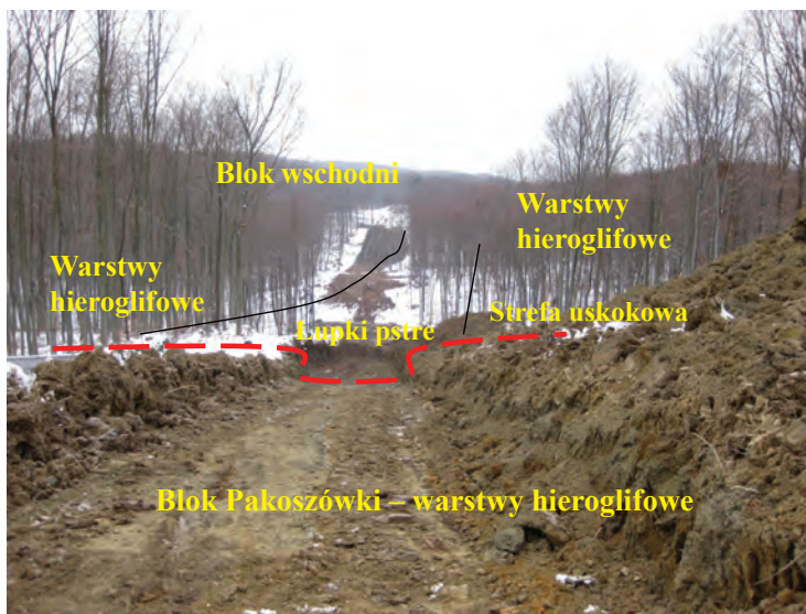
Rys. 8. Wykop główny do ośrodka grupowego wschodniego (z tyłu) z otworami SH.1–SH.4. W wykopie warstwy hieroglifowe, w głębi pstre
