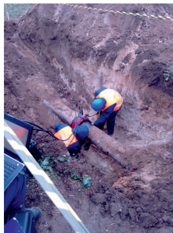
Rys. 3. Montaż aparatury pomiarowej podczas badań dla OGP GAZ-SYSTEM S.A.
